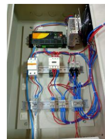
Gambar 10. Panel Listrik dan Perangkat IoT
