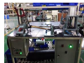
Gambar 11. Instalasi Panel Perangkat IoT
